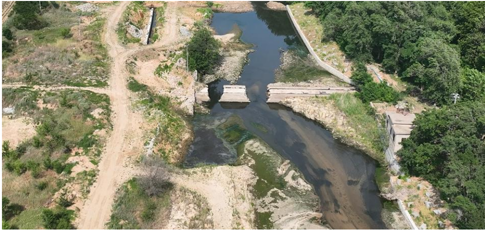
图 2-19 2024 年此处河道较窄阻塞河道拆除断桥（经调查为施工便道，目前已清理）
