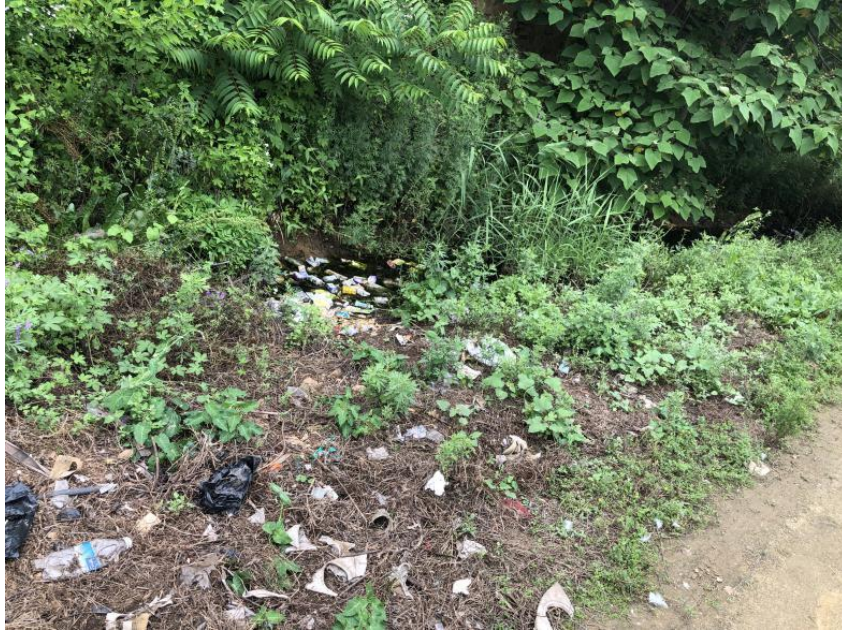
图 2-15 2021 年溢洪道垃圾较多（已于当年完成清理）
