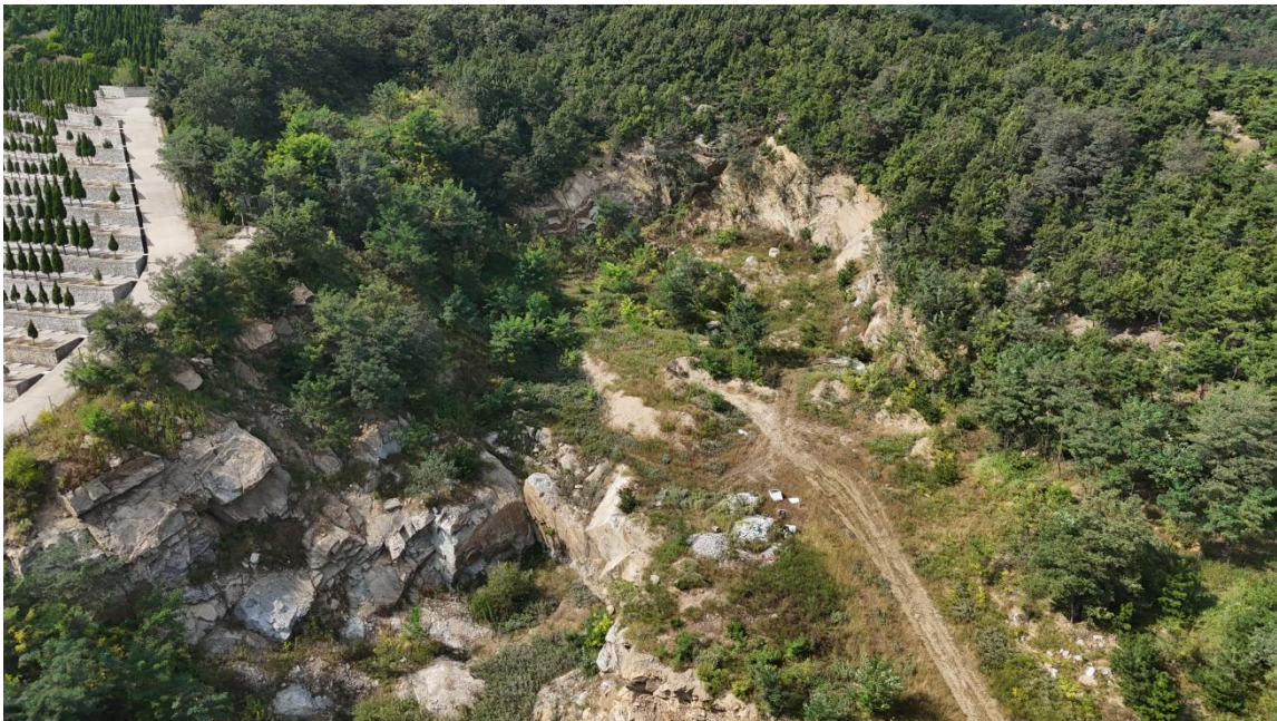
照片 2-30 南虎口村废弃矿坑航拍现状
