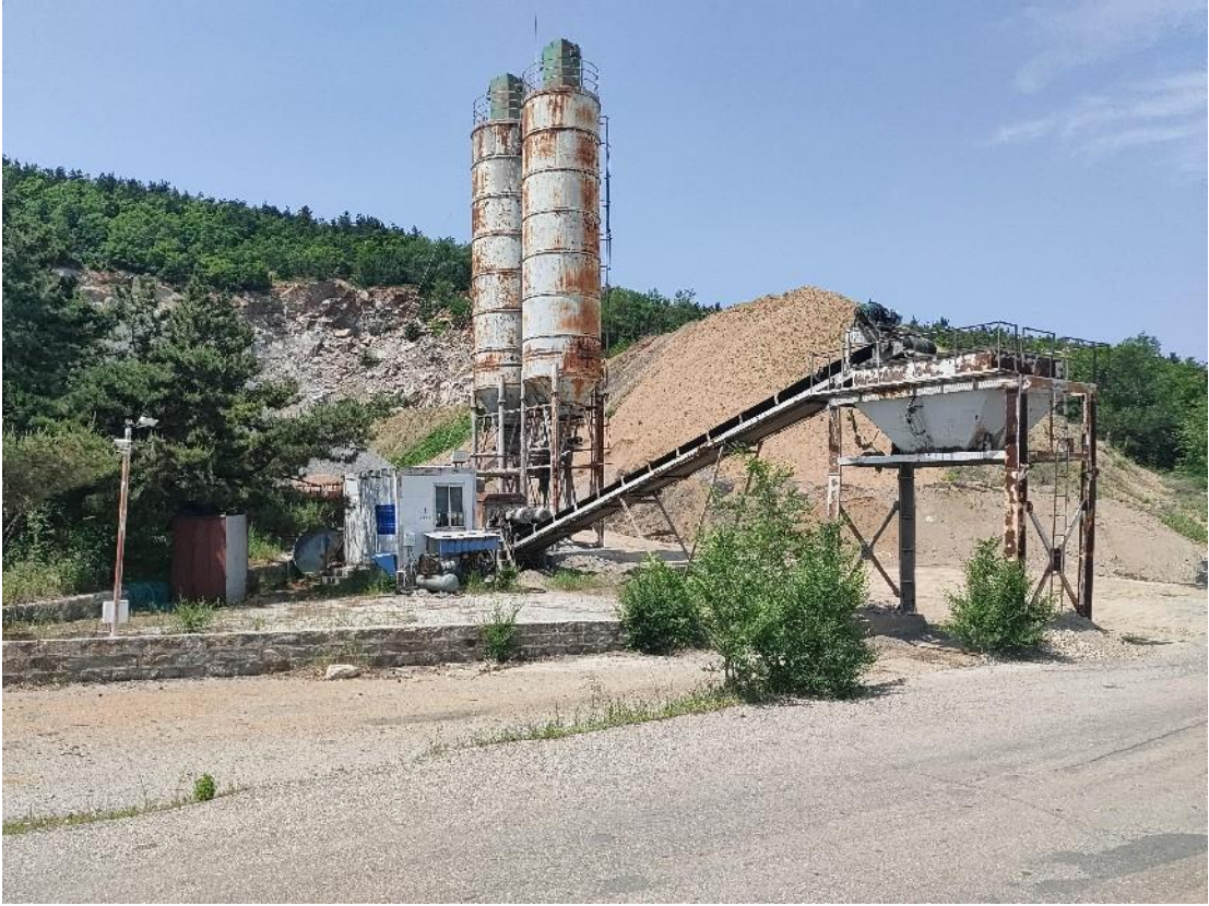
照片 2-15 北虎口 2 号废弃矿坑现状
